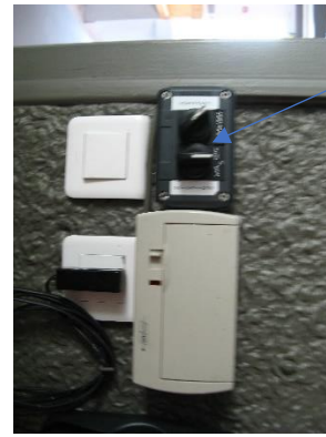
A côté du bar : Boutons pour enclencher la ventilation
