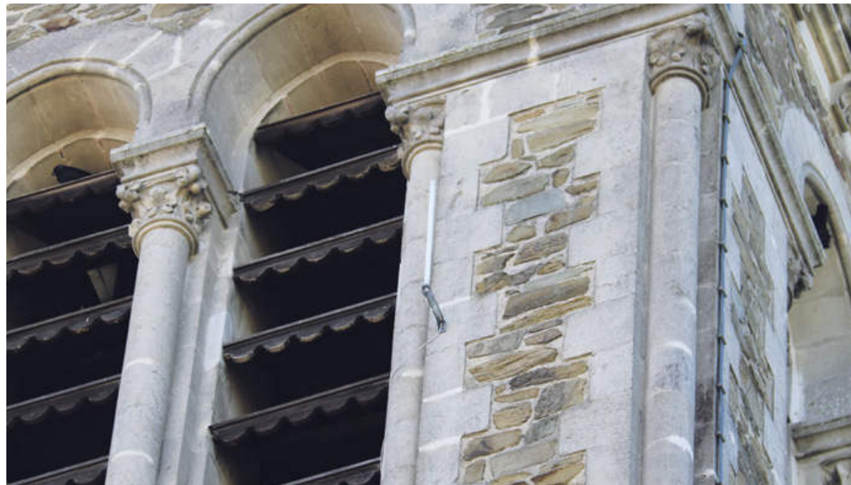
Exemple d'une passerelle réseau LoRa
